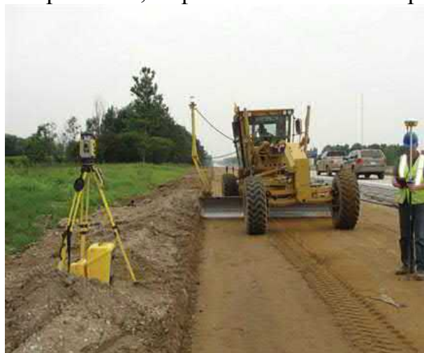
Рисунок 4 - Процесс проведения контроля качества работ на строительном объекте с использованием определенных инструментов
