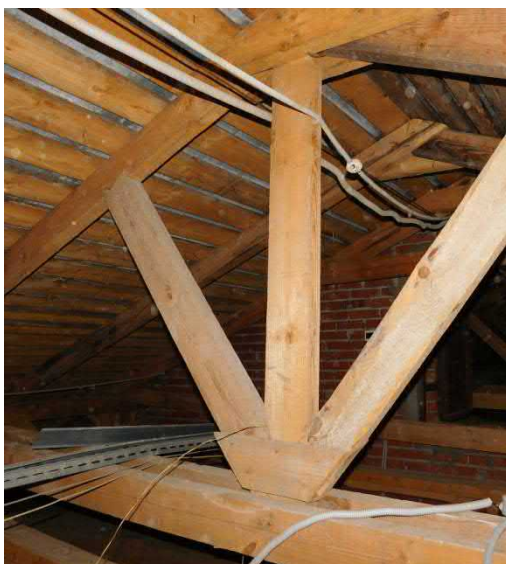
Рисунок 3 – Стропильная крыша торговых рядов
